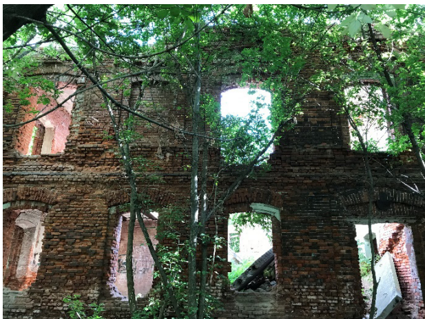
Рис. 7. Богадельня (приют для пожилых работников фабрики), современное состояние, 2022 год. Источник: фотография автора
