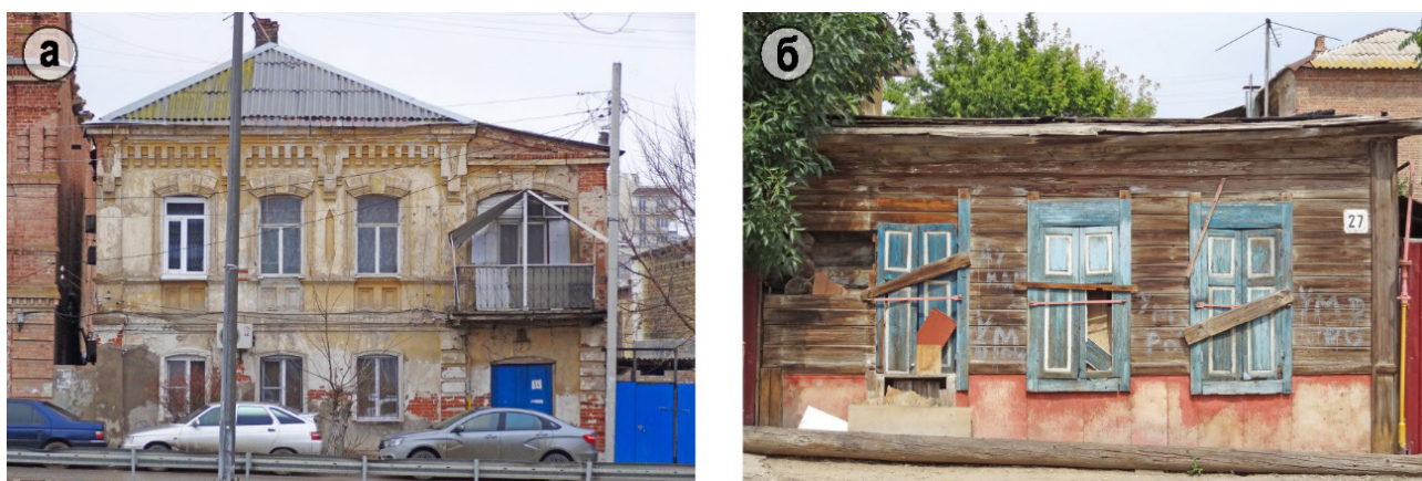
Рис. 2. Фотофиксации зданий по адресам: а – ул. Набережная 1 Мая, 54 (03.03.2021 г.); ул. Челюскинцев, 27 (09.08.2022 г.)
