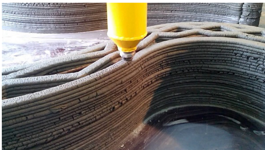
Рис. 1. Структура стены с использованием пространственной фермы
