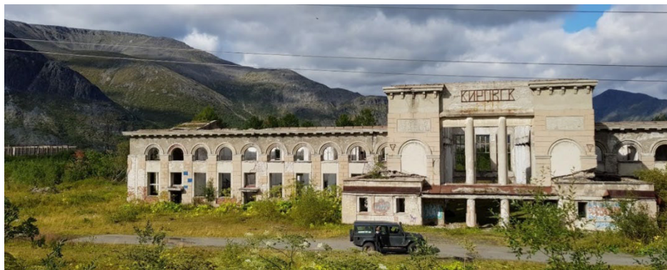
Рис. 4. Здание железнодорожного вокзала. Современное состояние
