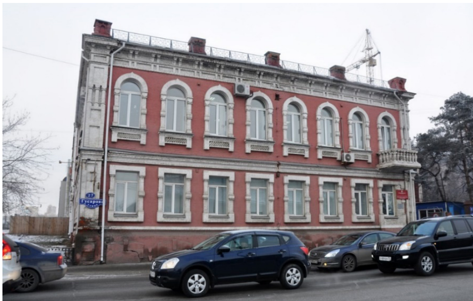
Рис. 1. Особняк купца Черткова, г. Омск, ул. Гусарова, д. 27
