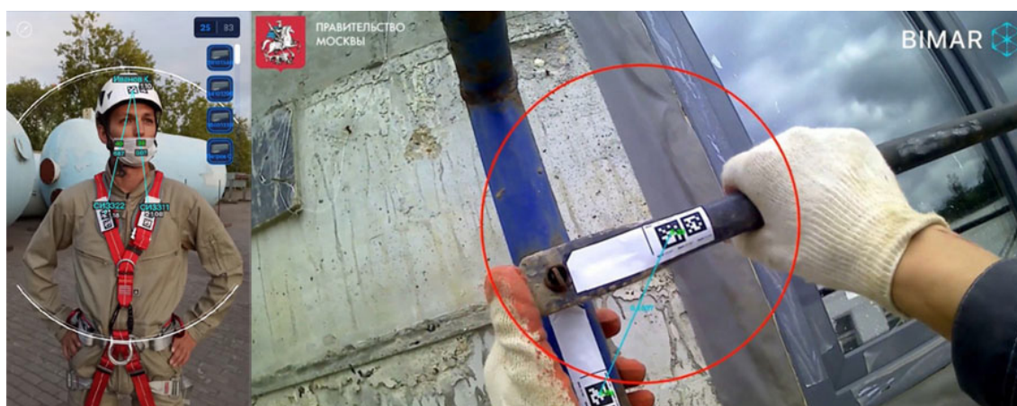
Рис. 3. Применение маркеров и ПО VimAR на стройплощадке в Москве
