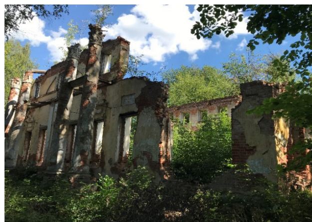
Рис. 6. Дом управляющего, современное состояние, 2022 год. Источник: фотография автора
