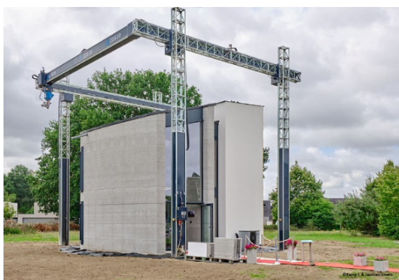
Рис. 2. Строительный 3D-принтер портального типа и типа «дельта»
