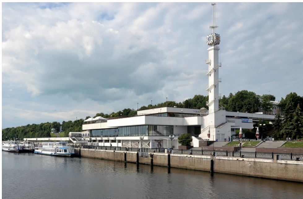
Рис. 2. Речной вокзал Ярославля. Современное состояние. Источник: domofoto.ru
